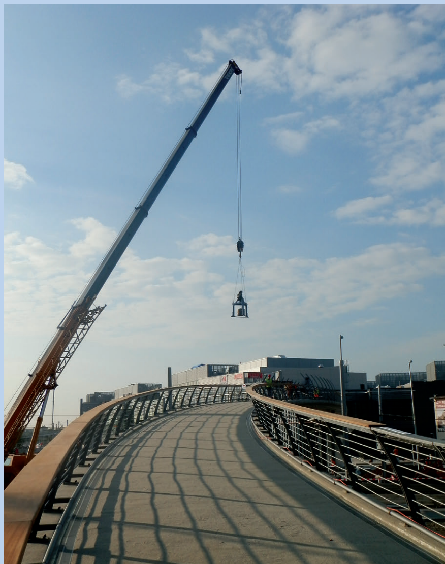
Statická zatěžovací zkouška mostu v Pňovanech přes vodní nádrž Hracholusky
