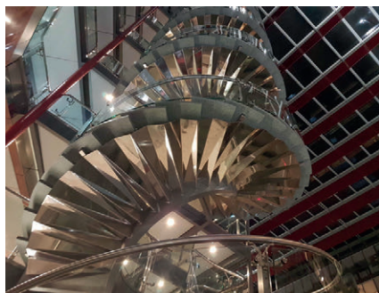
Posouzení statických a dynamických vlastností neobvyklé konstrukce schodiště administrativní budovy Nile House v Praze
