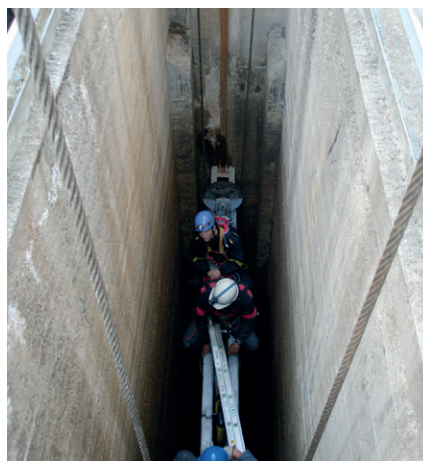
➤ Pracovníci Kloknerova ústavu posuzovali například stav rychlozávěrné tabule na přehradě Slapy.
