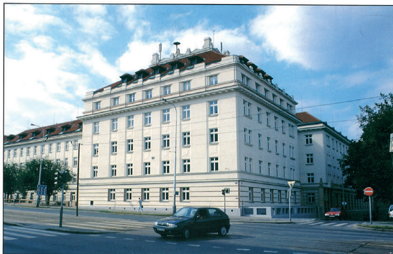
MASARYKOVA KOLEJ V DEJVICÍCH
