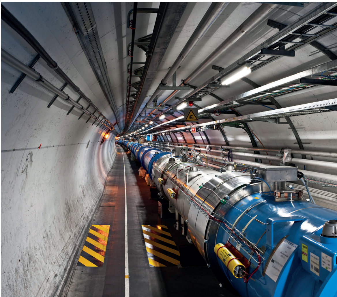
Large Hadron Collider (LHC) – částicový urychlovač o obvodu 27 km je umístěn 100 metrů pod zemí v laboratoři CERN.
