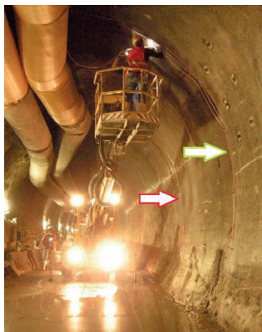
Instalace měřicích optických kabelů – metro V.A
